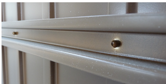
▲ Mocowanie poszycia do konstrukcji (widok od tyłu)
